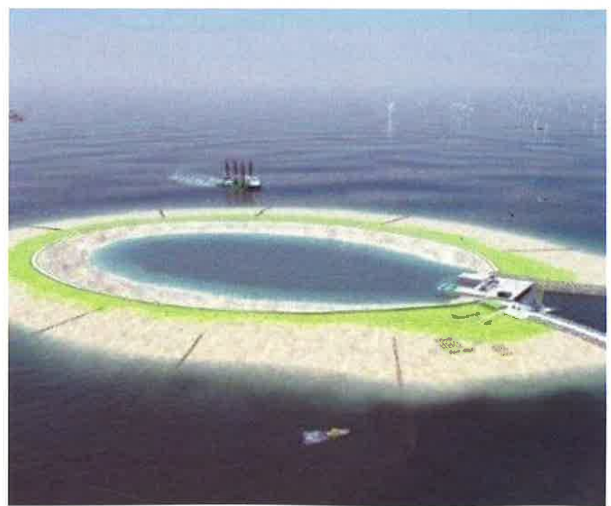
■ Een energie-atol of -eiland ziet er uit als een soort grote badkuip op zee. Met overtollige energie uit de windparken wordt het water er op gezette tijden uitgepompt, om vervolgens via turbines – op het ogenblik dat er weer meer vraag naar elektriciteit is – de kuip te laten instromen. De kuip is omgeven door een ringdijk en doet dus wel wat denken aan een tropisch ringeiland of atol ( www.destandaard.be )
